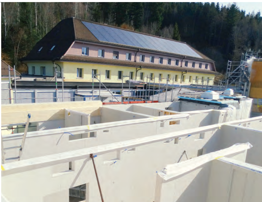
Болница Аделхайт, Швейцария. Заводски изработени панели с Vidiwall
