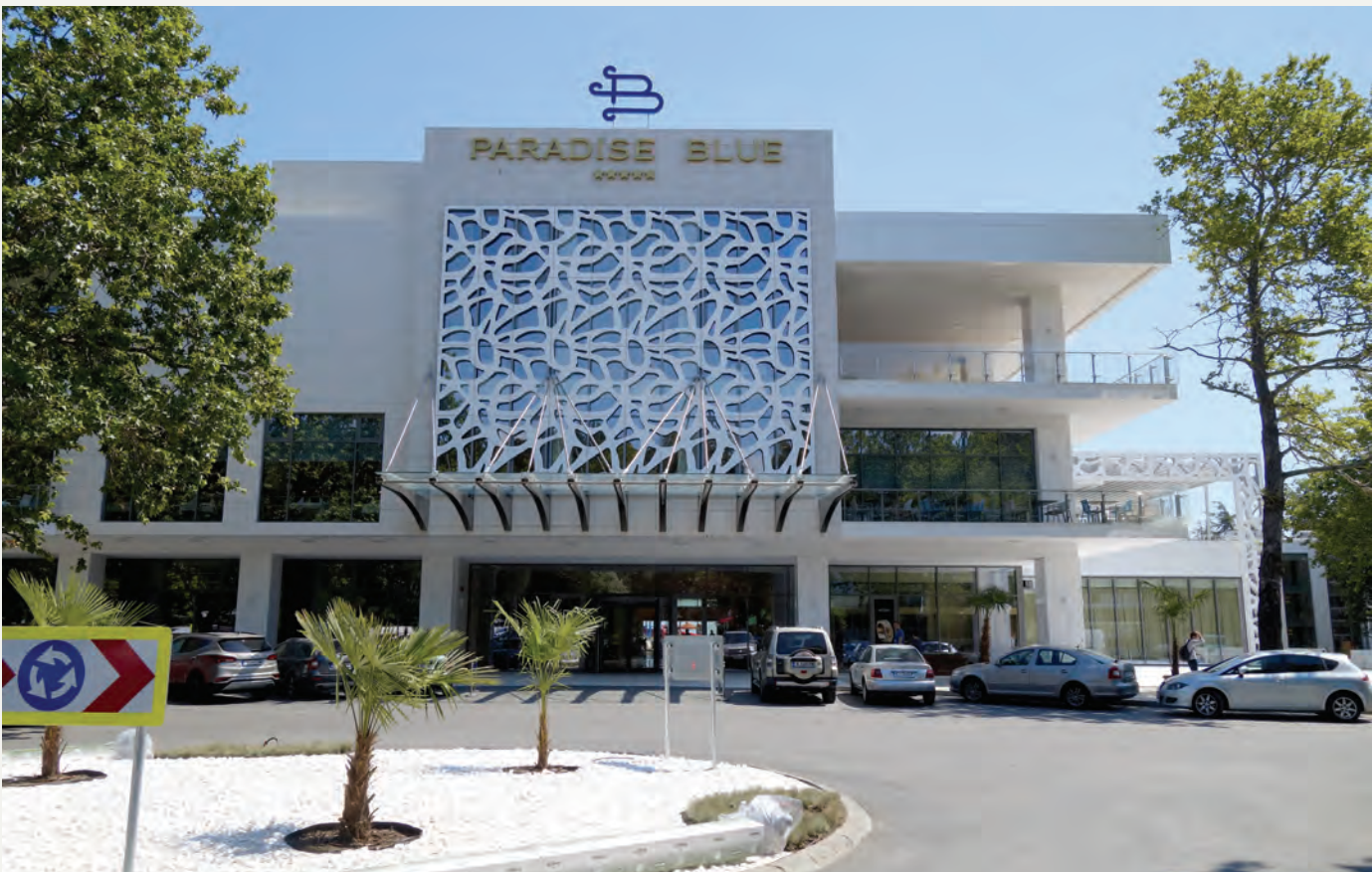
Хотел Парадайс Блу, Албена – сух под F135 Vidifloor DUO, влагоустойчиви стени с Vidiwall HI
