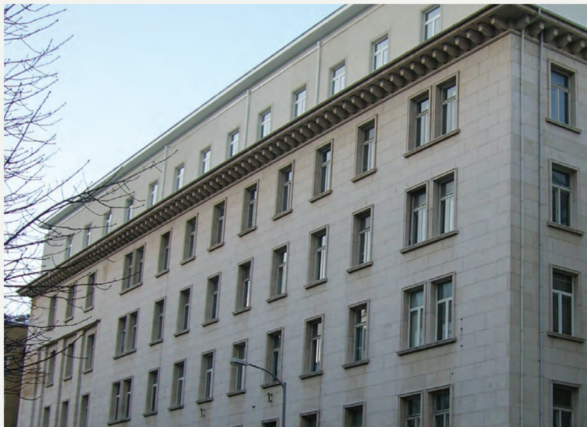
Атична надстройка на Върховния административен съд – огнезащита на стоманената конструкция, външни и вътрешни стени, сух под Vidifloor
