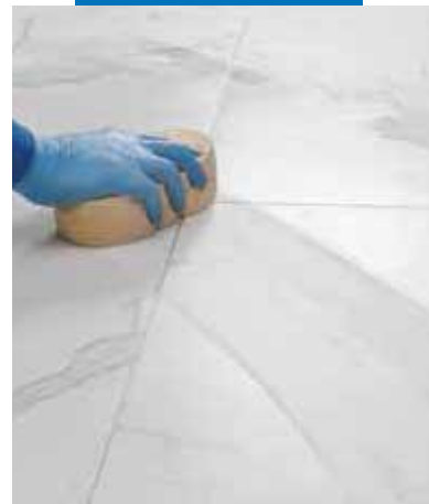
Почистване и довършване на фугите с твърда целулозна гъба
