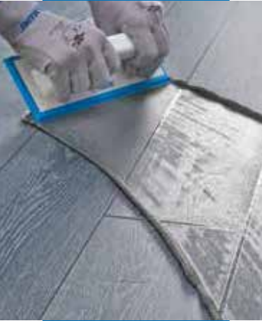
Разстилане на Ultracolor Plus върху подови гранитогресни плочки с ефект а дърво с гумена маламашка
