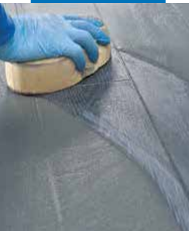
Почистване и довършване на фугите между плочки с помощта на гъба
