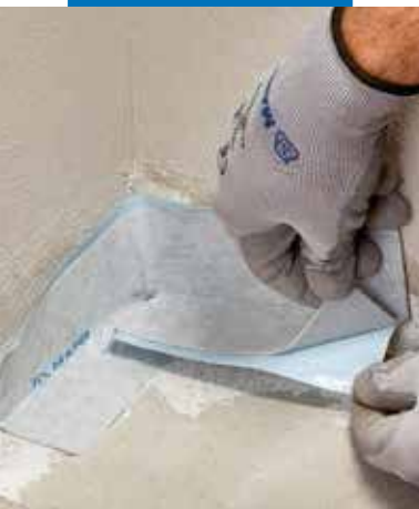
Полагане на Mapeband SA в ъгли
