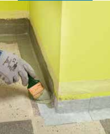
Полагане на Mapeband SA върху замазка
