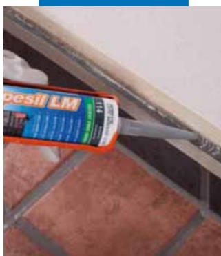
Уплътняване на холгерна връзка върху естествен камък
