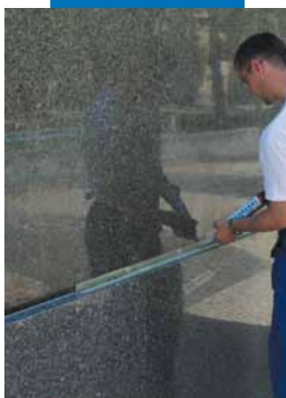
Уплътняване на фасадна фуга с Mapesil LM
