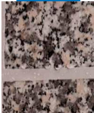
Уплътняване на челна фуга върху естествен камък
