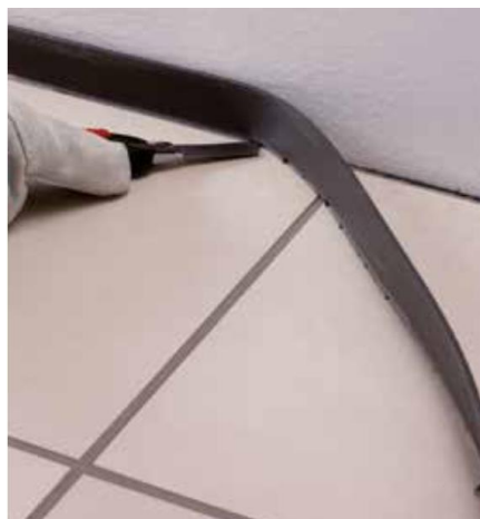
След втвърдяване на фугиращата смес, изрежете излишъка от лентата Mapesonic Strip по периметъра
