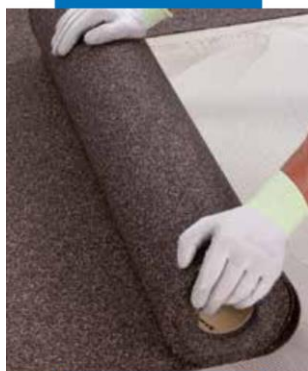
Разролеане на листите Mapesonic CR по повърхностите, които ще бъдат звукоизолирани
