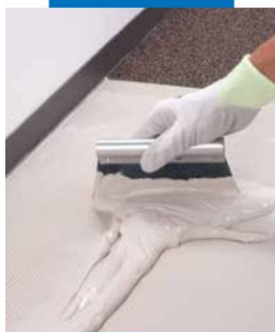
След подходяща подготовка на основата, разстилане на лепилото за залепване на звукоизолационните листи
