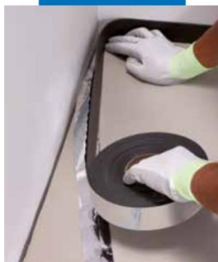
Полагане на залепваща лента Mapesonic Strip по периметъра на помещението
