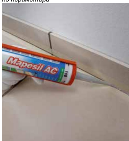
Уплътнете празнината между цокъла и пода с подходящ гъекав уплътнител от гамата на Mapei
