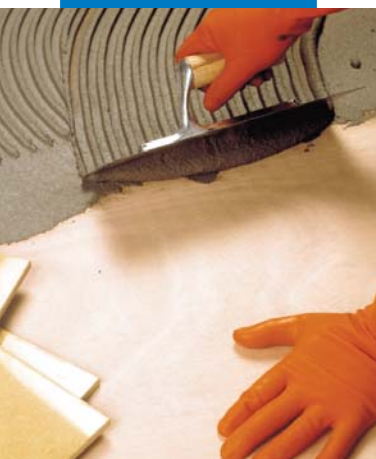
Полагане на порцеланови плочки върху основа от водоустойчив шперплат с Elastorapid
