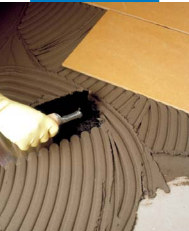
Полагане на Elastorapid върху замазка на циментова основа с назъбена мистрия
