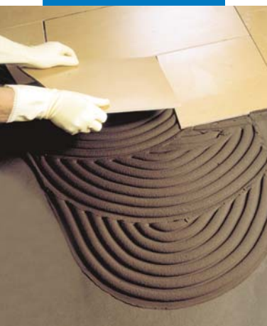
Полагане на порцеланови плочки върху замазка, която е хидроизолирана с Mapeelastic
